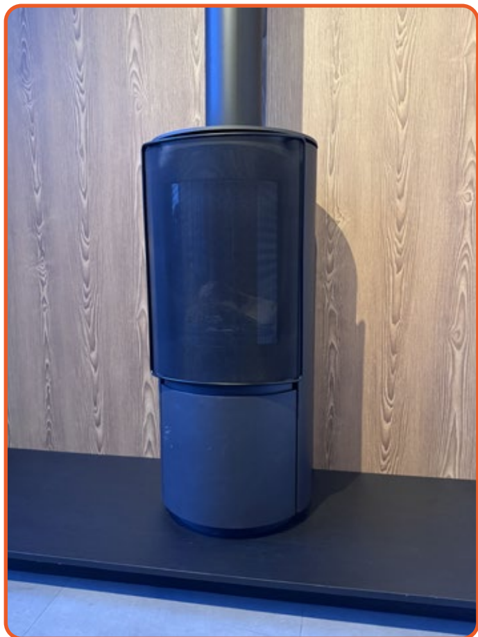
Figure 5.10 | Sicherheitsgitter installiert
