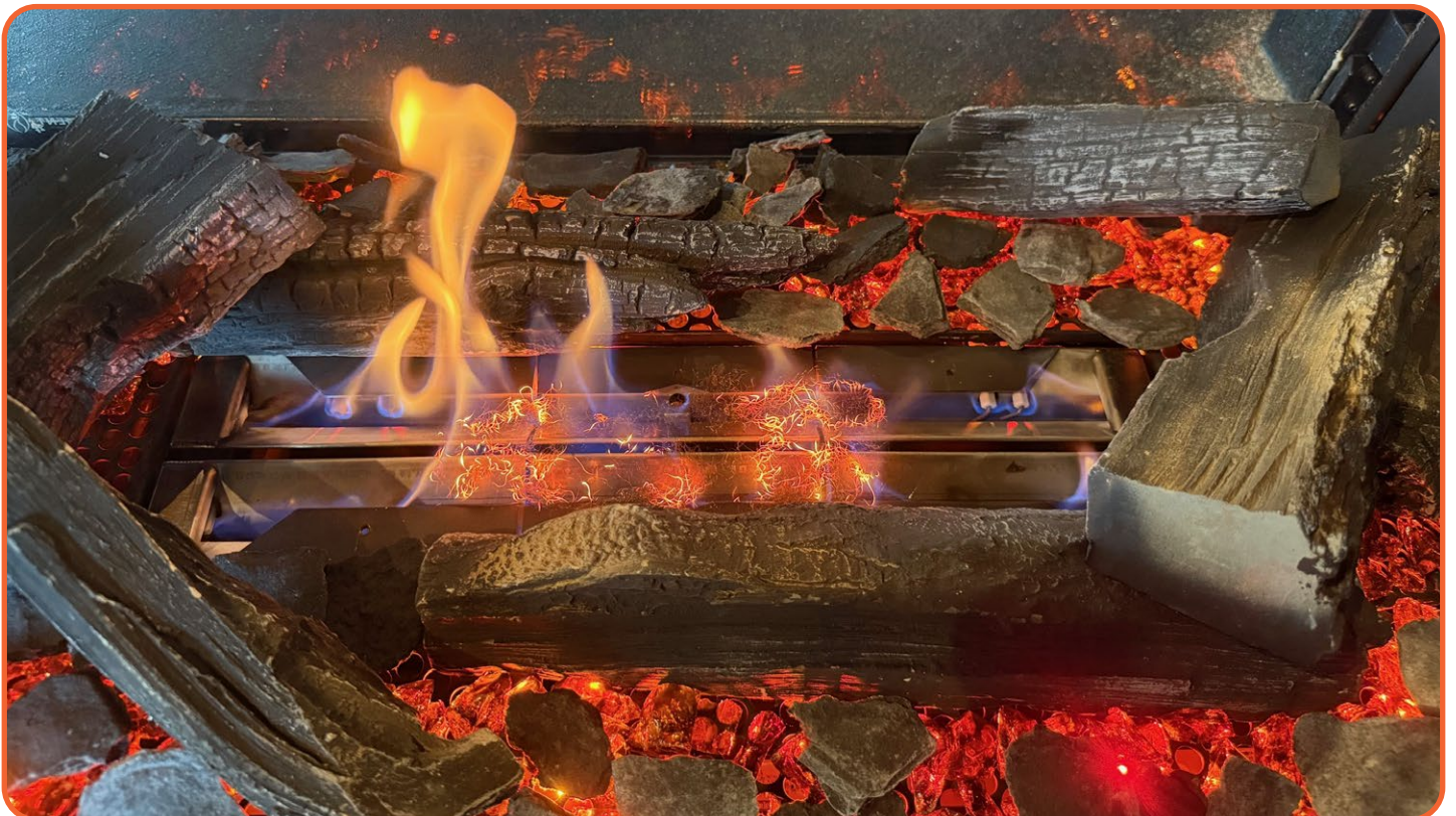
Vul de rest op met zwarte en grijze chips. Zorg er wel voor dat het branderrooster open genoeg blijft zodat er lucht door aangezogen kan worden.
